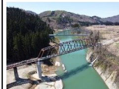
令和元年竣工 只見線災害復旧他工事
